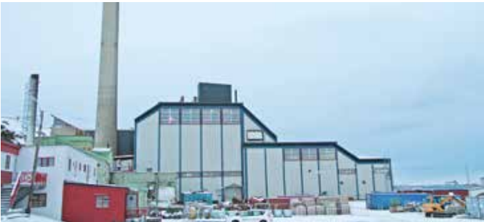
Energiverket ligger i utkanten av Longyearbyen og forsyner hele området med elektrisitet. Foto: Vette Daler.
